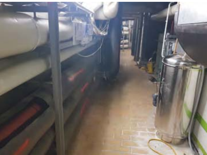
Bestandsanlage vor der Sanierung
